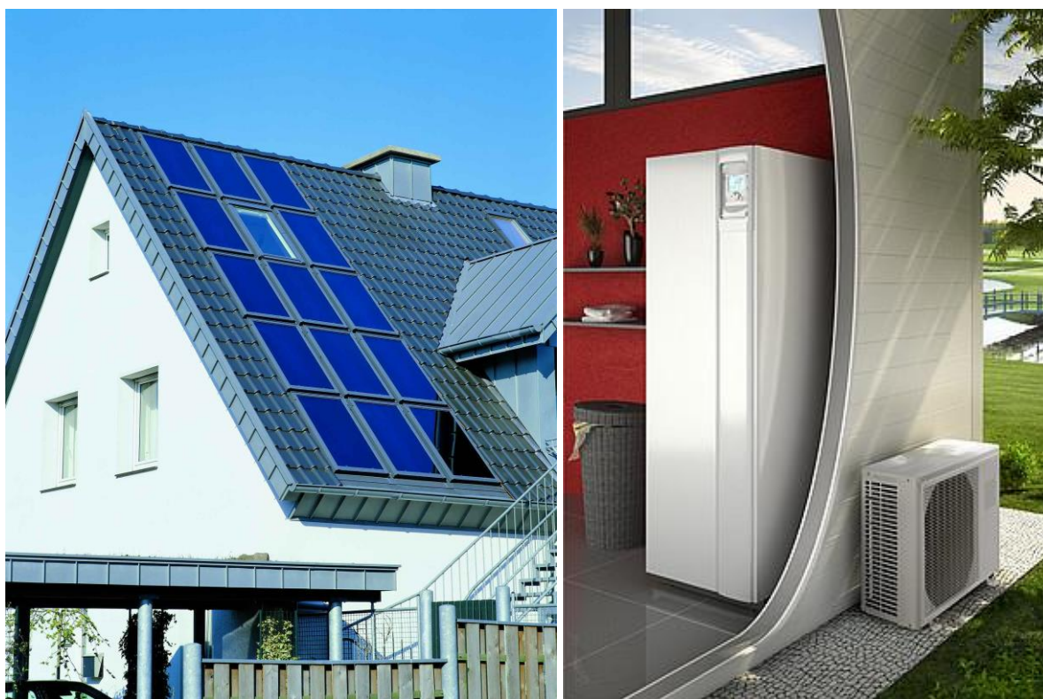
Figure 3. Exemples de systèmes de chauffage efficaces - Installation solaire thermique (photo de gauche ; Source : ESTIF) et Pompe à chaleur Air-Air (photo de droite ; Source: EHI)
